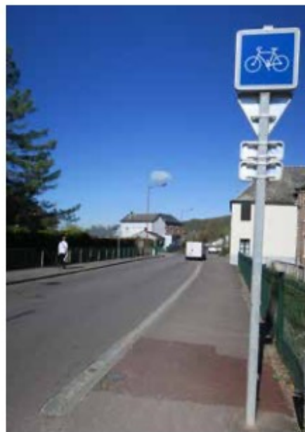
Création d'un cheminement cyclable aux abords de la D321 à Pont-Saint-Pierre
